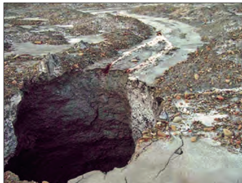
Мал. 2. Карстове провалля на автомобільній дорозі (Івано-Франківська область).
