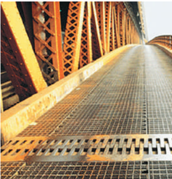
Рис. 2.6. Щоб міст не вигинався під час спеки й не руйнувався в мороз, його виготовляють з окремих секцій, з'єднаних спеціальними зчленуваннями (ряди зубців змикаються під час спеки й розходяться під час морозів)
